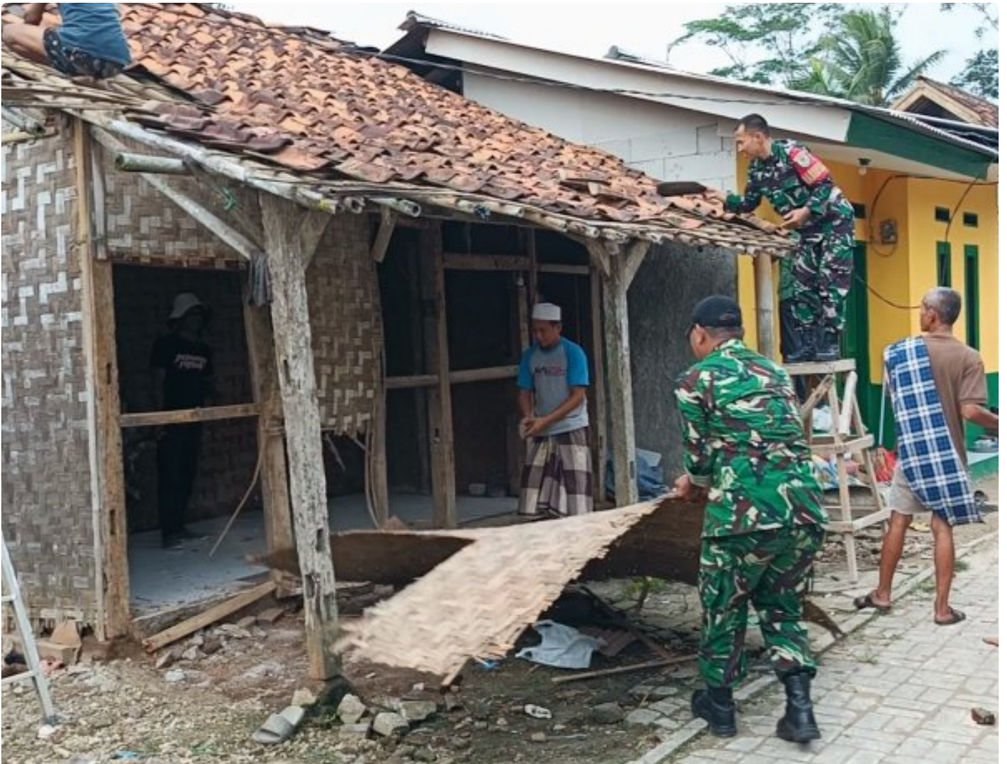
Pembongkaran Rumah Bapak Narmin
